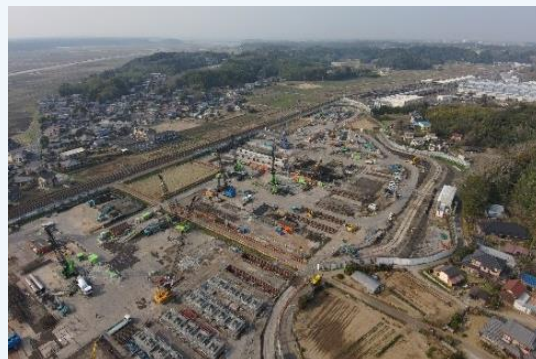
宗吾車両基地拡充工事
