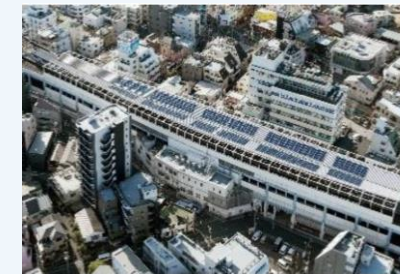
太陽光パネルの設置
