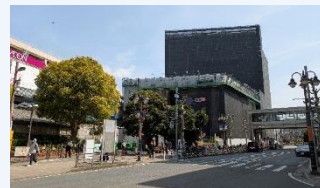
津田沼12番街ビル（改修工事中）
